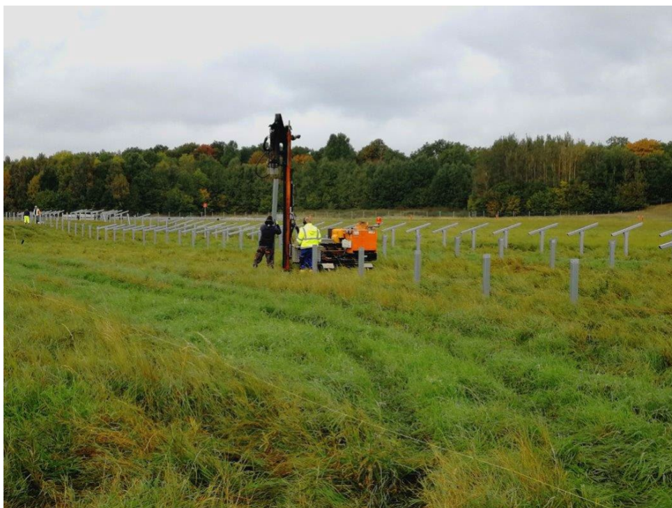
Figur 6 Exempel på pålningsmetod för solpark , Solkompaniet ©.
