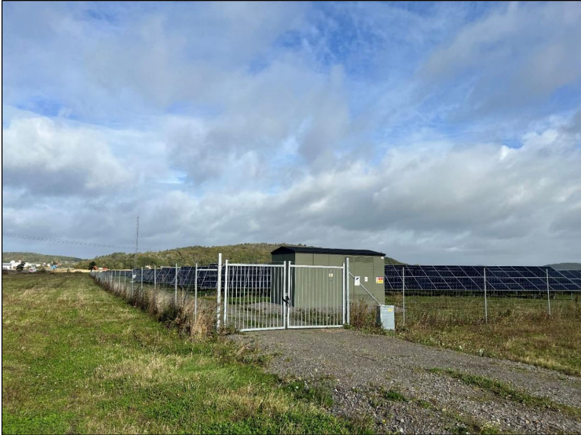
Figur 5. Exempel på utformning av staket och grind vid infart. Foto: Solpark Varberg Norra.
