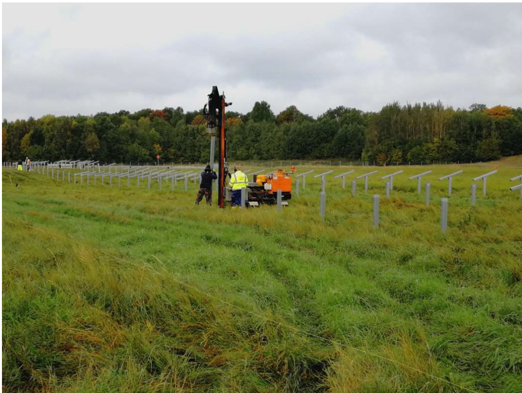
Figur 5. Exempelbild pålningsmaskin för infästning av pålar i marken.
