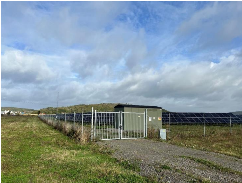
Figur 4.4.1. Exempel på utformning av staket och grind vid infart, bild tagen vid Solparken Varberg Norra.
