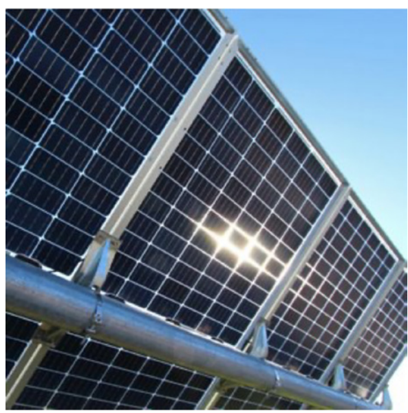
Bifaciala paneler är dubbelsidiga vilket gör att både det direkta och det reflekterade solljuset absorberas och omvandlas till el.
