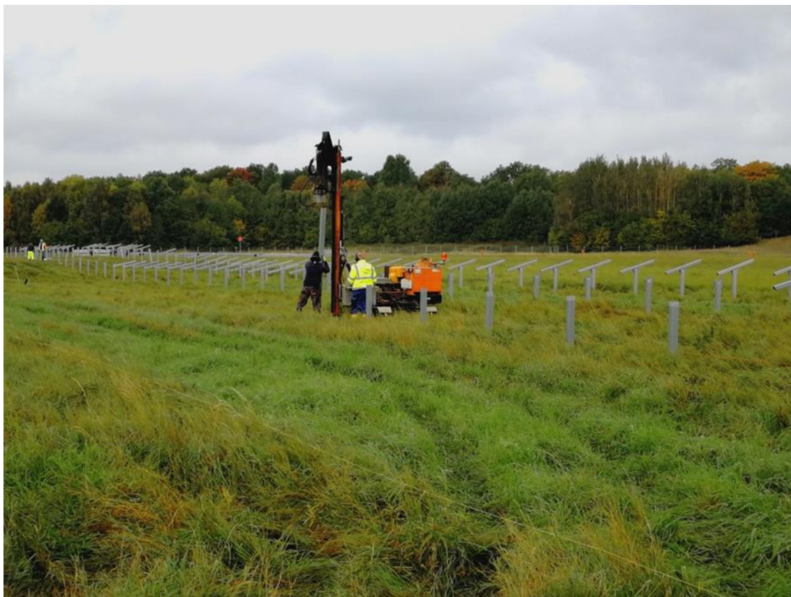
Figur 4. Exempelbild som visar montering av pölar som fästs i marken med hjälp av en pölningsmaskin. (Foto: Solkompaniet)
