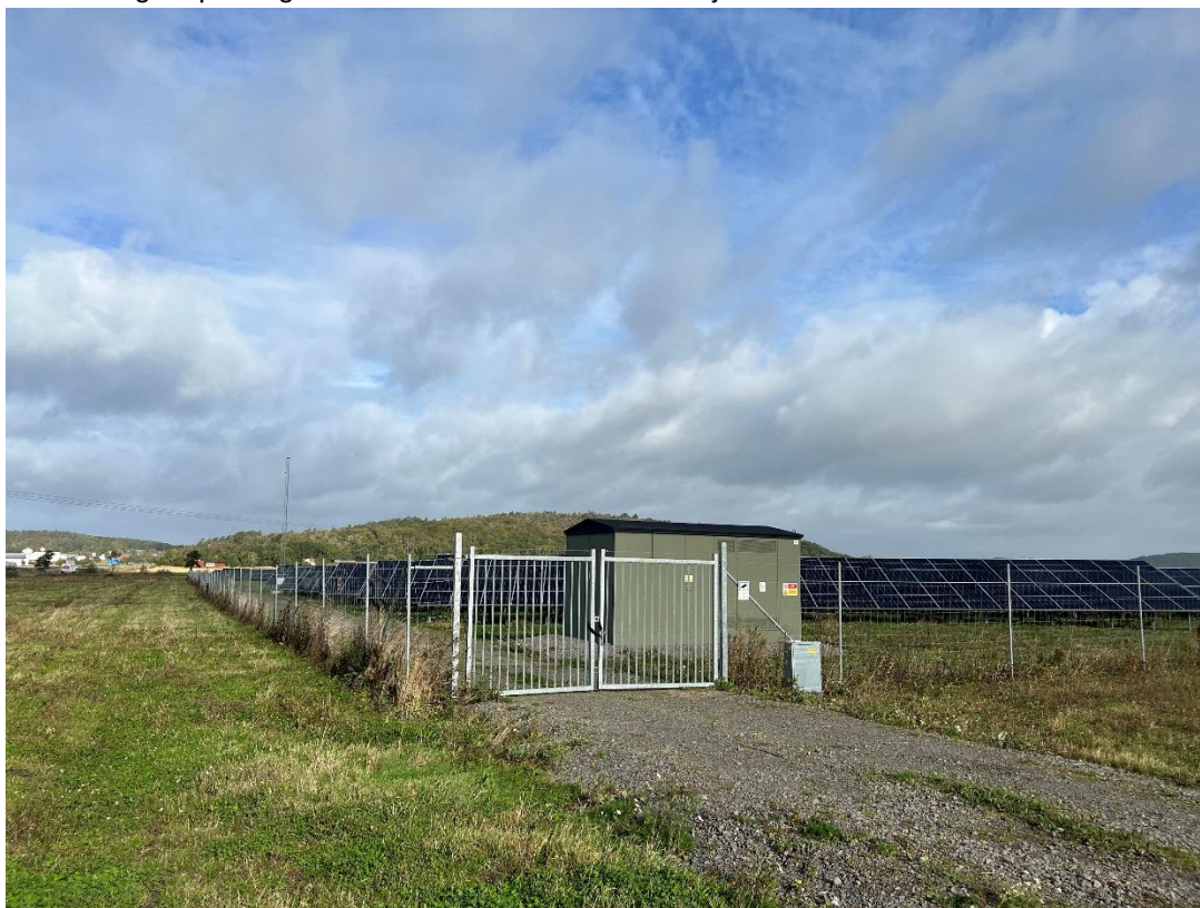
Figur 6. Exempel på staket och grind vid infarten till Solpark Varberg norra.
