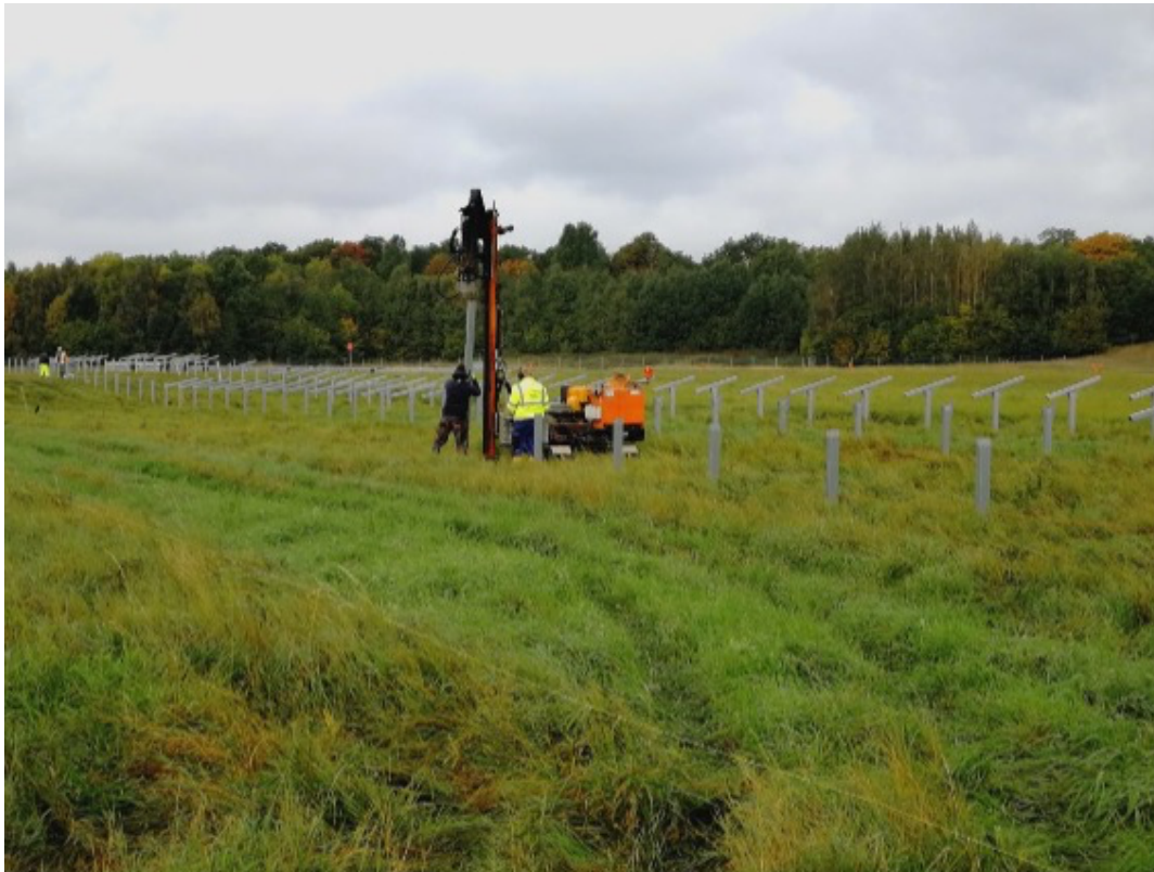
Figur 6. Exempel på pålningsmaskin för infästning av pålar i marken som solpanelerna ska monteras på (Foto: Solkompaniet).
