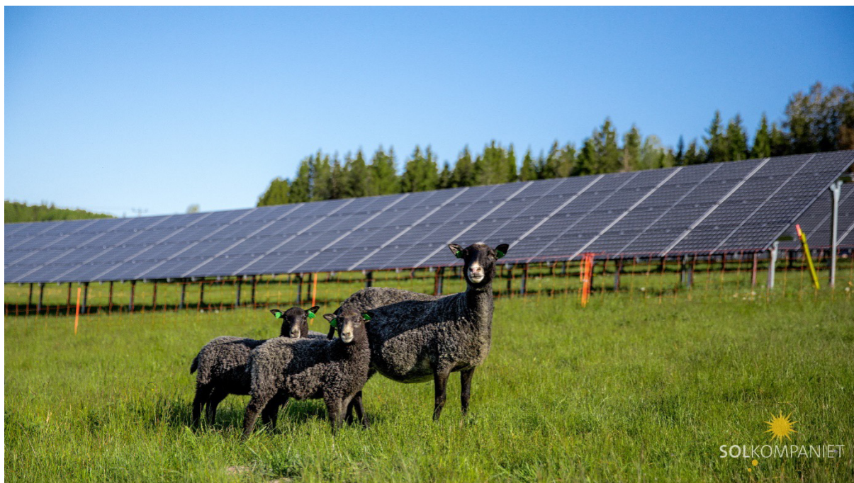
Figur 1. Foto från Lunde Energis Solpark i Torphyttan som Solkompaniet har byggt.
