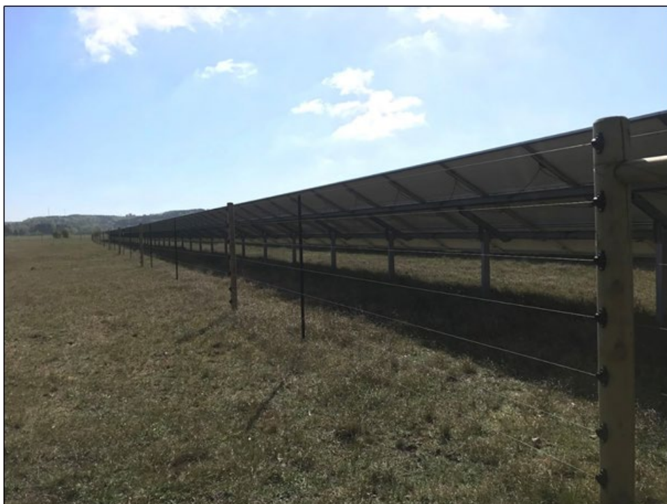
Figur 17. Bild på stängsel och solceller på fastigheten Sjöbo Sövde 32:3
