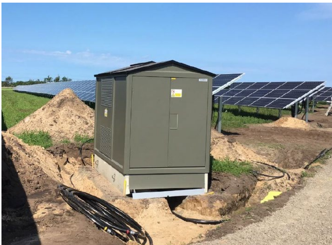
Figur 16. Exempelbild transformatorstation under byggnation av solcellspark i Varberg. Även en del av schakt är med på bild.
