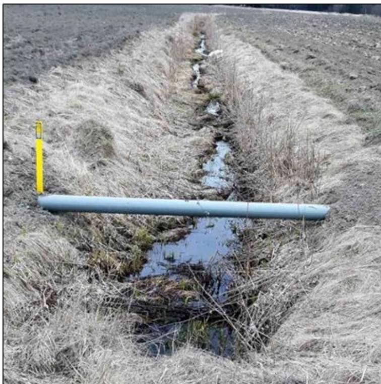
Figur 14. Exempel på kabeldragning i metallrör över dike.
